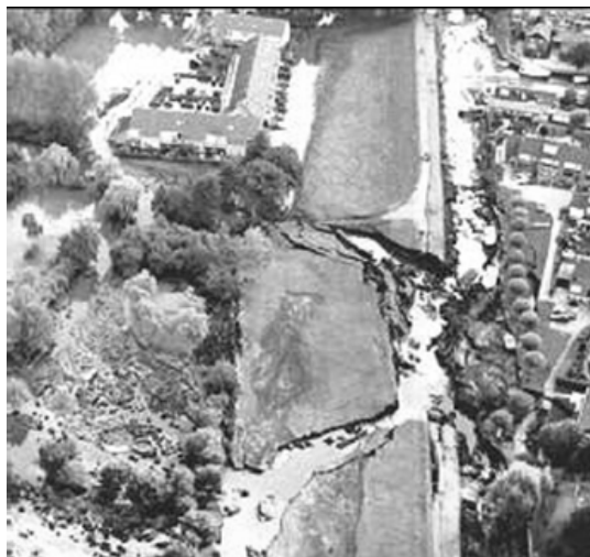
Figure 3 - Wilnis peat dyke failure (van Baars 2005).
