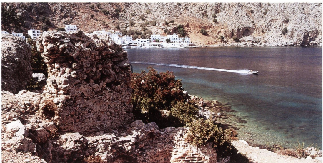
C Loutro: collapsed bathhouse
