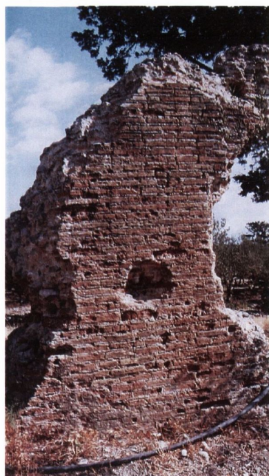
C Ini : aqueduct elevation
