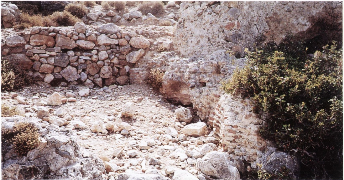
B Loutro: collapsed bathhouse
