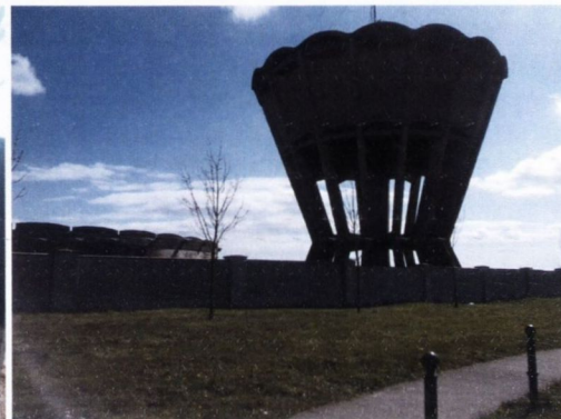
(d) Water tower at high elevation
