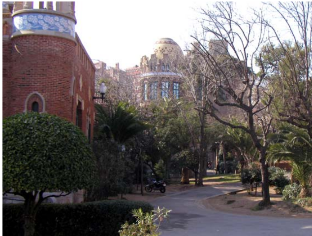
Hospital de la Sante Creu, Barcelona
